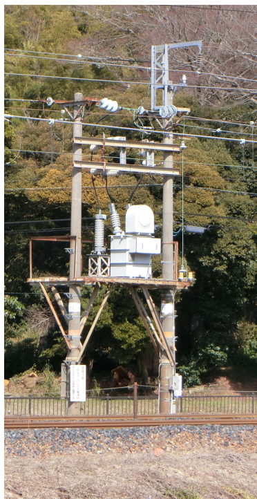
ハピラインふくい線 北陸トンネル南口付近
