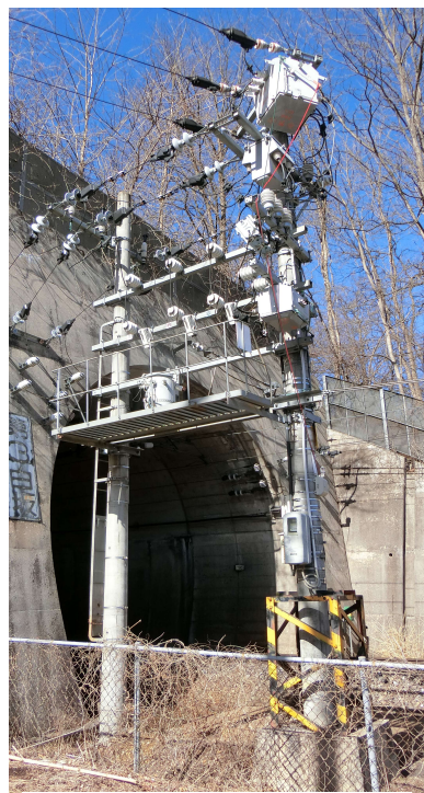
篠ノ井線 第3白坂トンネル北口
